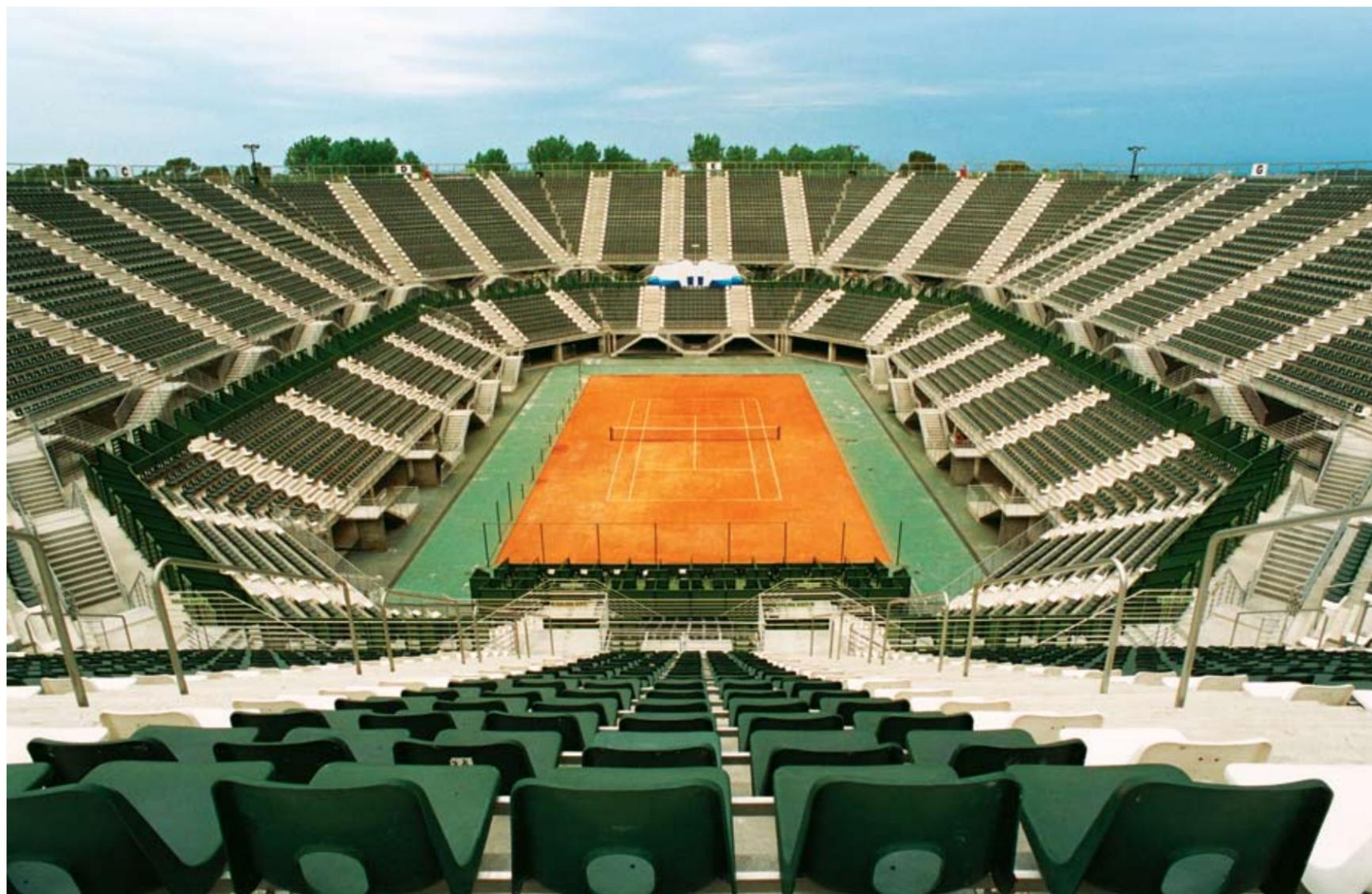
turales. Las condiciones visuales óptimas respetan la curva isóptica de 15 cm entre cabeza y cabeza. Posee fluidez en la circulación de los espectadores.
